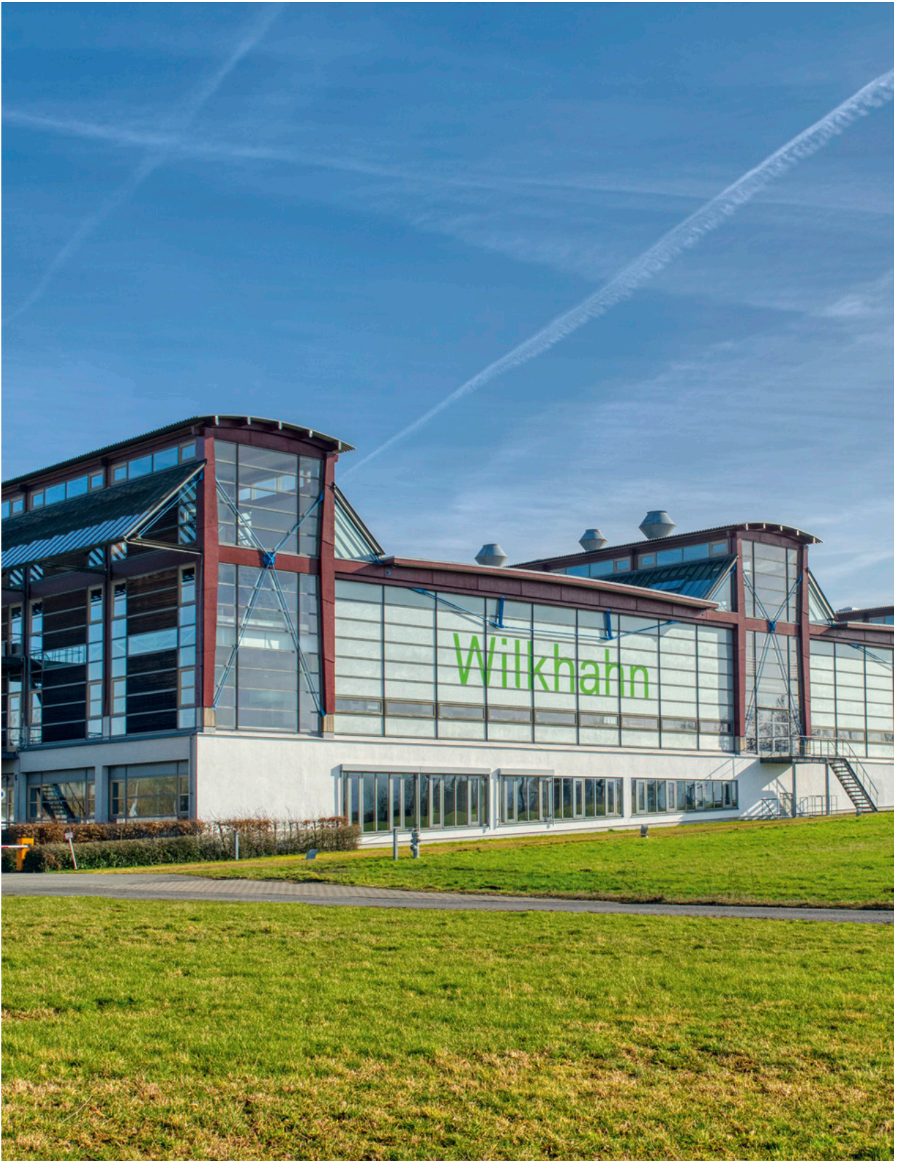
Wilkhahn-Fabrik, Bad Münden, Deutschland; Architektur: Thomas Herzog; Foto: Mandy Will
