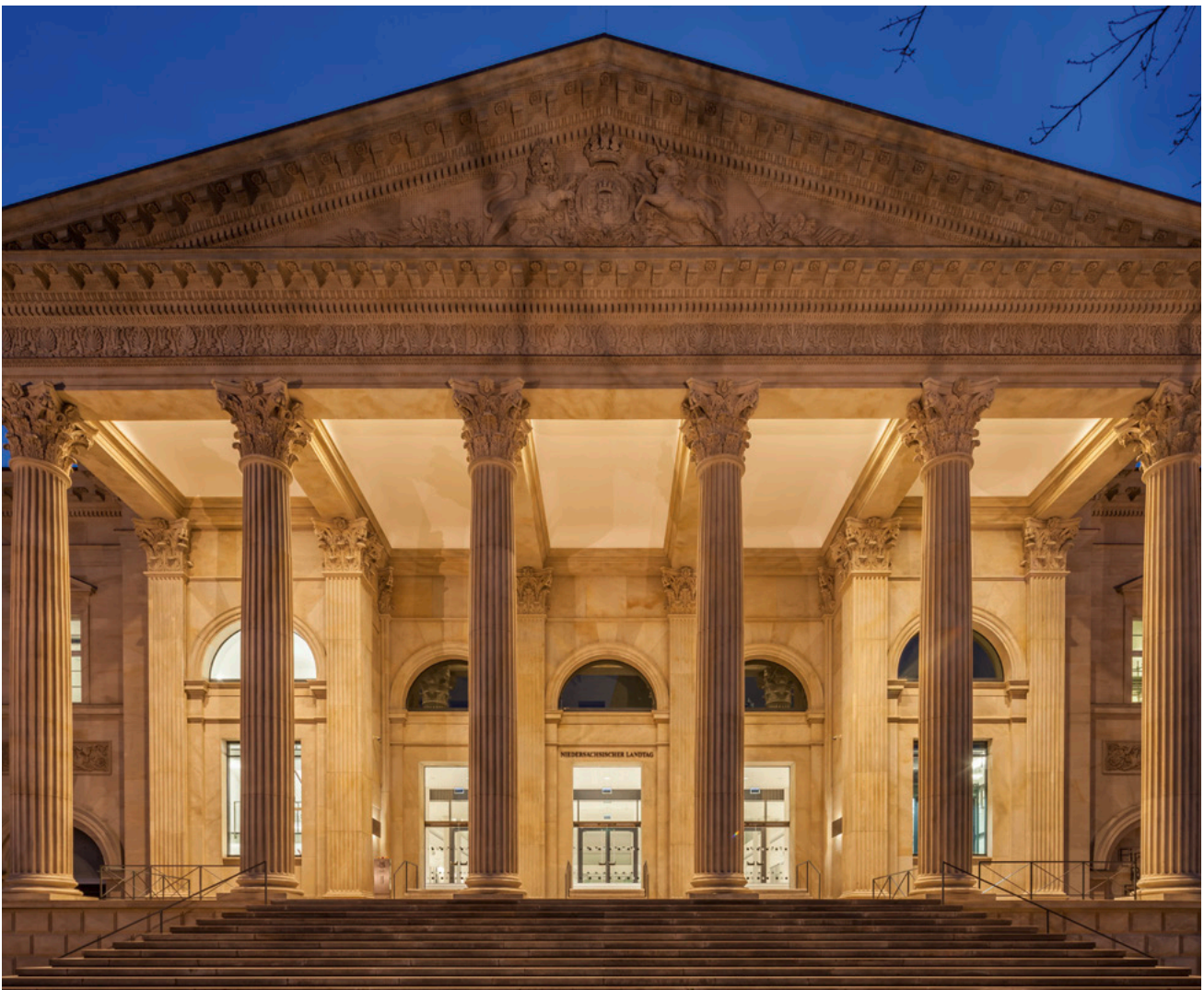
Die von Georg Ludwig Friedrich Laves gestaltete klassizistische Fassade des ehemaligen Leineschlusses dient als Haupteingang für den neuen tageslichtdurchfluteten Portikus, der als zentraler Verteiler fungiert.
