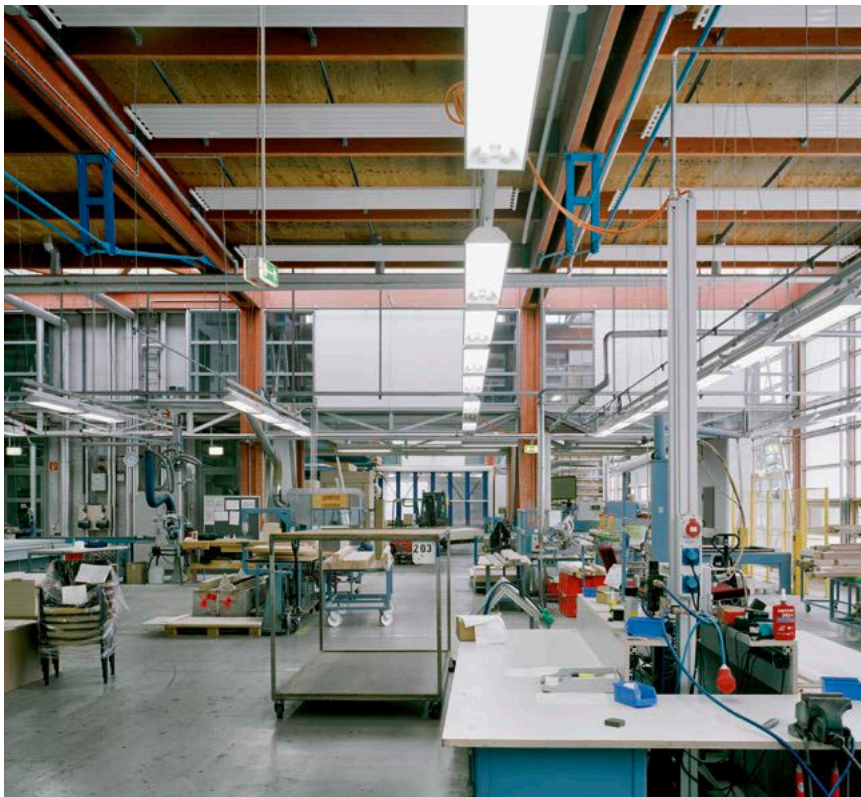
Bild links: Holztragwerke, Dachbegrünung, Tageslichtnutzung und innovative Solartechnik setzten 1992 neue Standards für eine nachhaltige Industriearchitektur – und wirken so aktuell wie am ersten Tag.
